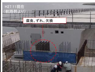
P4、P9に設置している鋼製の落橋防止装置に □遠望目視で腐食、ずれ、欠損はないか?
