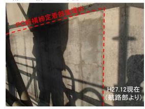
□遠望目視でPC桁横締定着部の後埋め筒所に 「浮き」等はないか。
