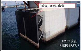
□P6.P7に設置している防舷材に 損傷、変形、腐食はないか?
